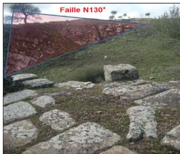
Photo 03 : Translation du pavé de la rue principale E-W sous l'effet d'une faille de direction N130.
