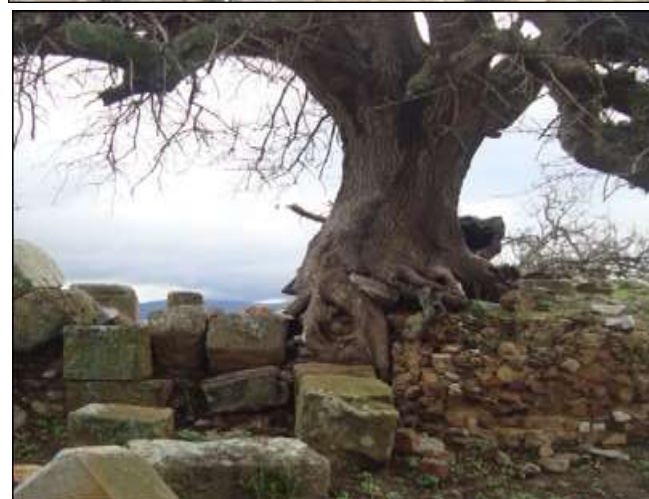
Photos 02 : Prolifération des racines en provoquant une déstabilisation des soubassements des murs et des structures fragiles.
