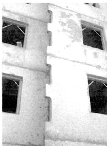
Photo N°5 : Couvre-joint en granitex à la place du mastic d'étanchéité.
