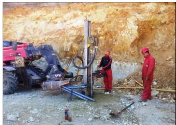
FIGURE 3. Installation de micropieux
