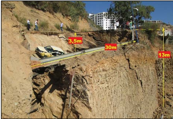
FIGURE 1. Vue sur le site
