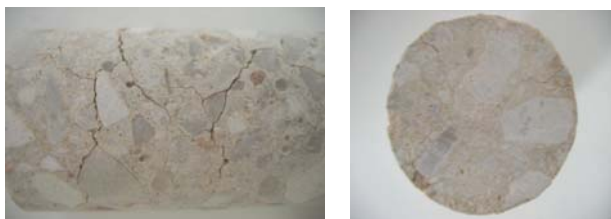
Figure 7 : Photographie de l'échantillon de béton CEMII/59 ayant subi l'immersion/séchage à 60°C.
