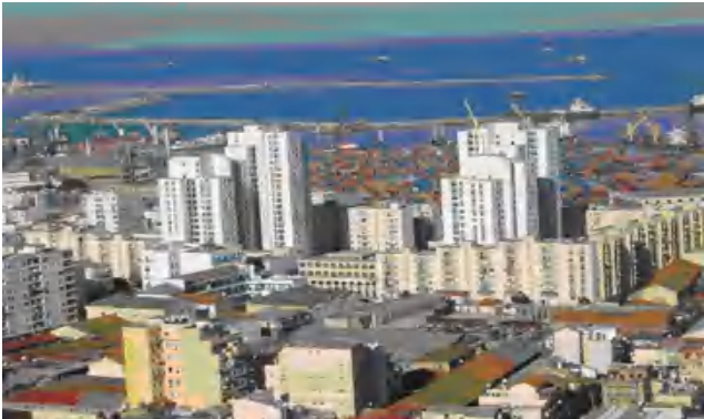
أبراج أنشطة المكاتب باللون الأبيض بالقرب من الميناء والتي أنجزت في إطار مشروع إعادة الهيكلة بالحامة الذي انطلق منذ منتصف الثمانينيات، باستعادة الأراضي بعد هدم المباني القديمة، هذه الأبراج غير مستعملة رغم ما يزيد عن عشر سنوات من إنجازها، تصوير الباحث 2004
