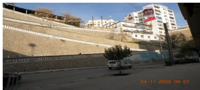
Photo 9 : (les S) un enchevêtrement de murs de soutènement reliant deux grandes artères de la ville. Source : Hamrouchi K.
