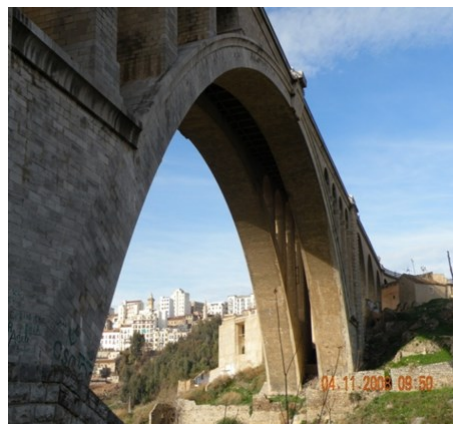
Photo 5: la grande arche (70m) du pont sidi Rached Source : Hamrouchi K.
