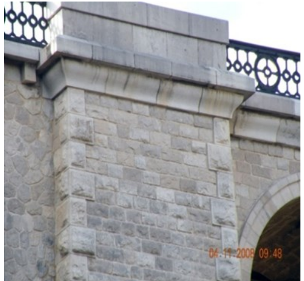
Photo 3 : Un des piliers du Pont Sidi Rached avec couronnement et harpes
