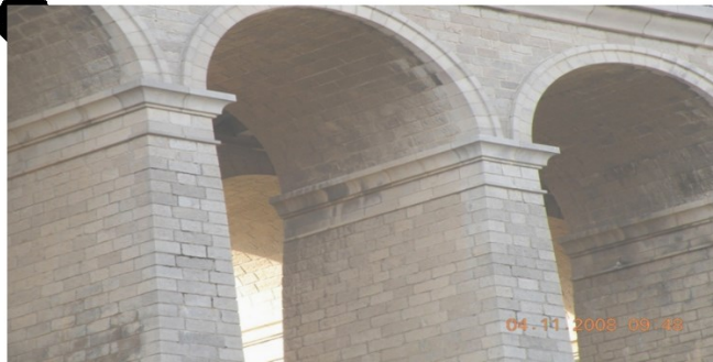
Photo 1 : quelques arches du pont Sidi Rached qui en compte 26 ; un monument symbole de la ville.
