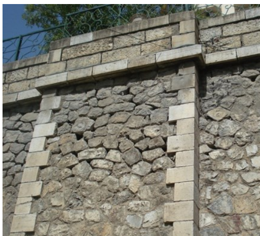
Photo 8 : mur de soutènement avec contrefort. Source : Hamrouchi K
