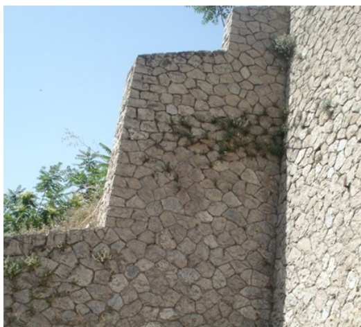
Photo 7 : mur de soutènement avec couronnement et harpe. Source : Hamrouchi K.
