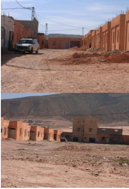
شكل 13: الطرق ومواقف السيارات احتلت ما يقدر بـ 40% من المساحة الإجمالية، وهي في حالة متدهورة وغير مهيأة، أما الشبكات الأخرى كمياه الشرب، الصرف الصحي والكهرباء فموجودة بالحي ما عدا شبكة الغاز. المصدر: إنجاز الباحثين
