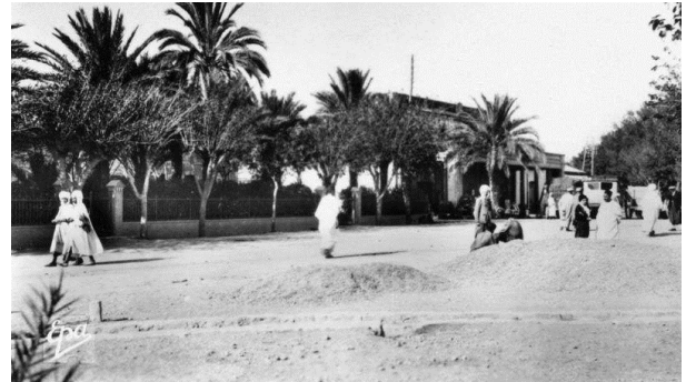
travaux d'aménagement de la place 1942 effectués en 1946
