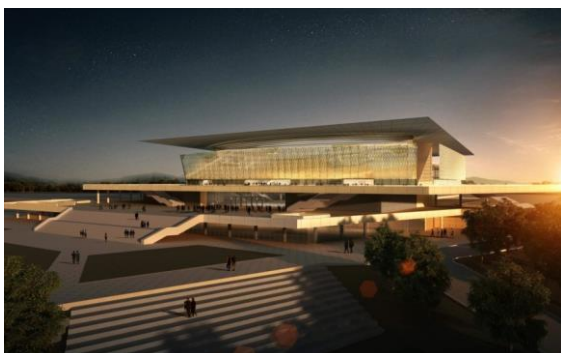
(fig. 7) La salle de spectacle Ahmed bey (ex Zenith) (Source: direction des équipements publics DEP Constantine 2015)
