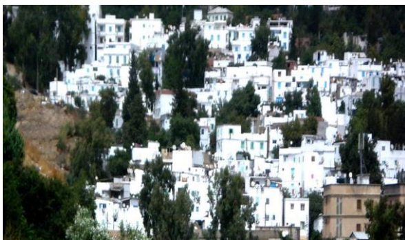
(fig. 6) : Opération d'amélioration urbaine, cité Bidilouiza en face de Marriott. (Source: A.Bouchareb & H. Ariane)
