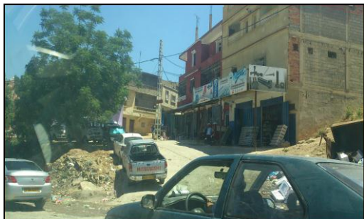
Fig. n° 5: Le caractère inachevé des habitations, l'entrée Nord-ouest (RN27)
