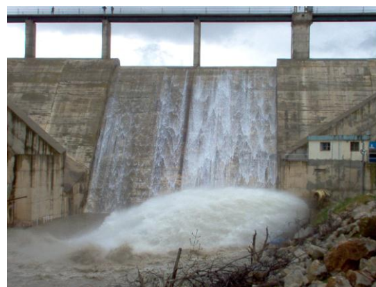
Photo 1 et 2 : Vue amont et aval du barrage de Hammam Grouz.
