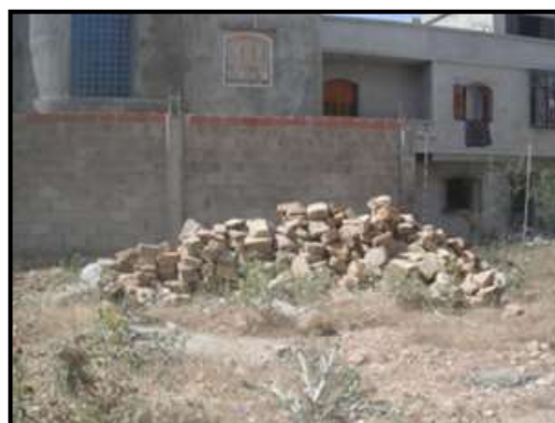
Photo 30 : dépôt de matériaux de charge dans un lot voisin
