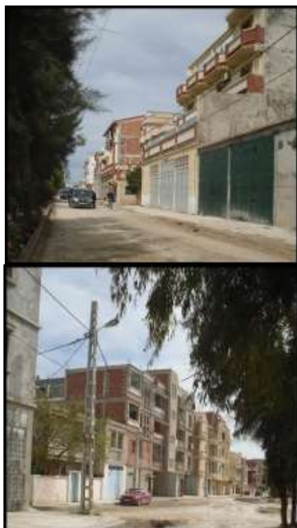
Photo 11,12 : Images de maisons présentant le contraste entre les façades (Source : l'auteur 2015)
