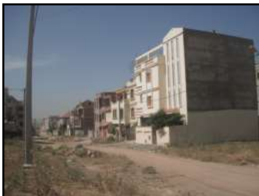
Photo 26 : manque des travaux de viabilité
