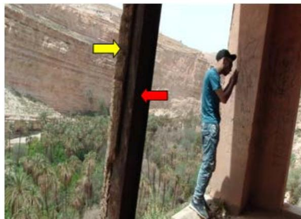
**Photos N°20, 21 :** Structure métallique recouverte par des troncs de palmiers
