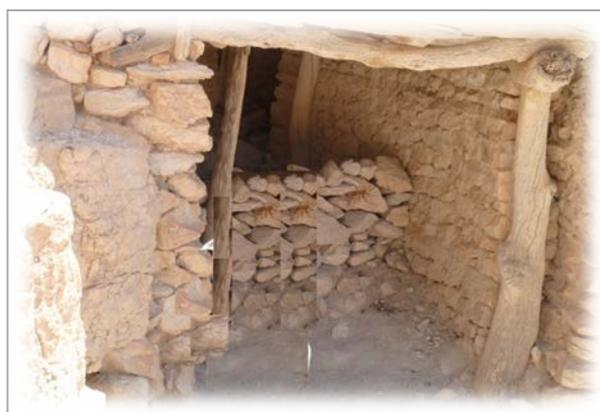
**Photo N°16 :** Structure porteuse en troncs d'arbre. **Source :** Auteur/2016
