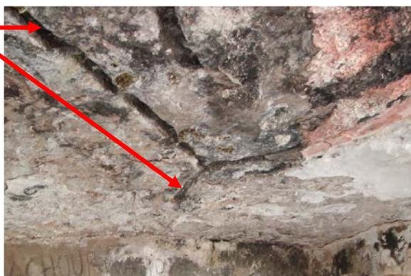
**Photo N°19 :** Plafond de la chambre avec les petites rigoles pour la récupération des eaux pluviales
