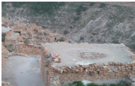
**Photo N° 13 :** Une maison de forme cubique, terrasses en argile prise à partir du 2<sup>ème</sup> balcon
