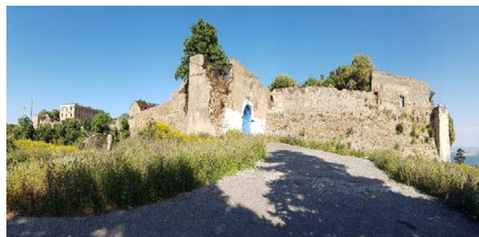
Photo 6 : Vue extérieure de la Citadelle Source : Auteur 2017
