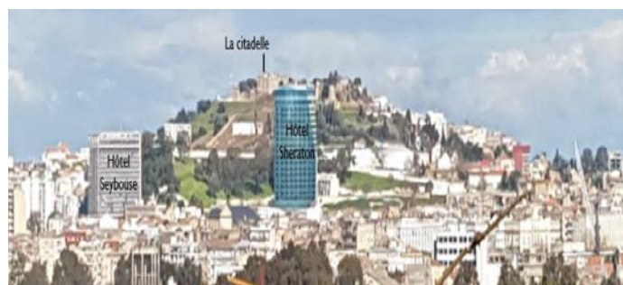
Photo 16 : Vue sur la citadelle depuis la Basilique St Augustin Annaba. Source : Auteur 2017
