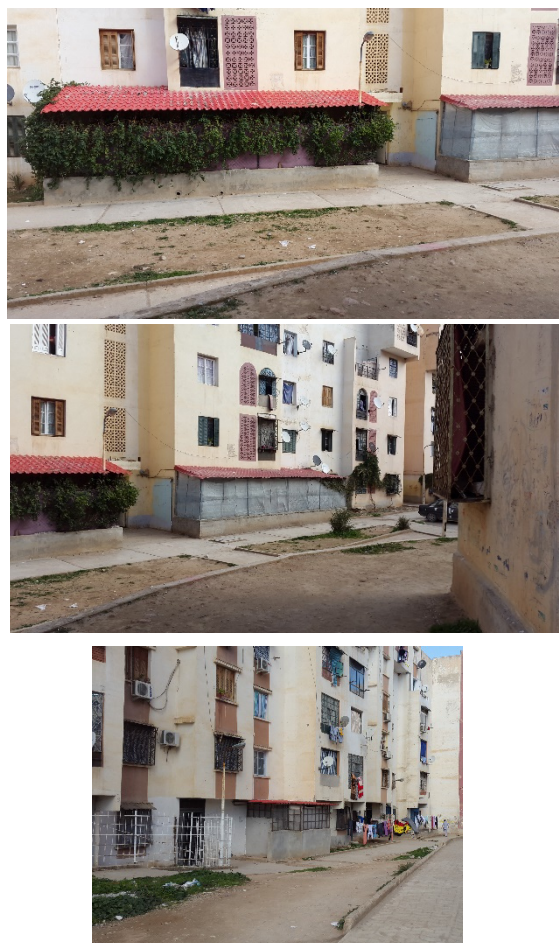
Figure 6 : Habitants qui utilisent le même procédé pour s'approprier les pieds d'immeubles
