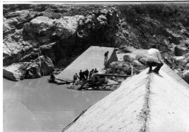
**Photos. 2 et 3.** Vue générale des dégâts sur le bassin de dissipation, crue des 27 et 28 mars 1973. (Source : ANBT barrage de Cheffia, 2015).
