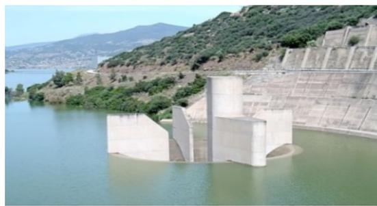
**Photo 4.** Evacuateur de crue en puits de section circulaire (barrage Hammam Debagh) (A.N.B.T, 2014).
