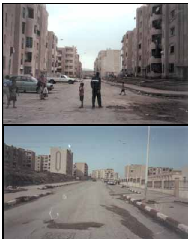
Fig.4 : Espacement et largeurs des voies entre les bâtiments au niveau du site d'étude de l'UV7. Source : Auteur, 2004
