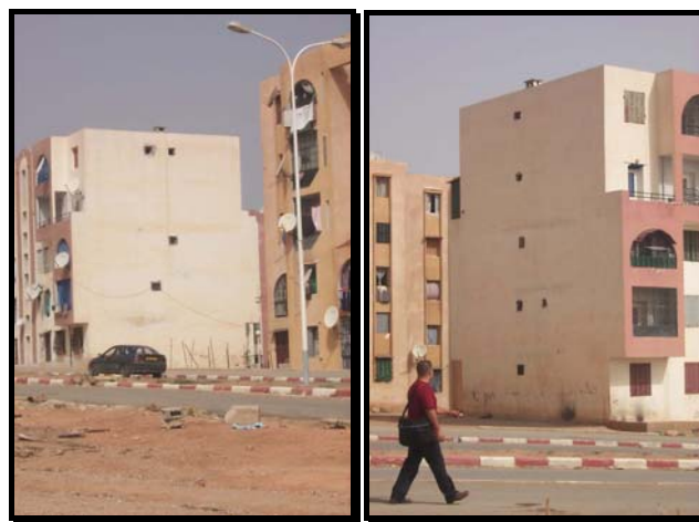
Fig. 12: Le percement d'ouvertures (Unité de Voisinage 08)
