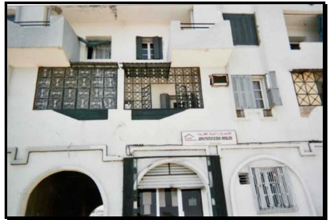
Fig. 11: Le vis-à-vis dans la ville nouvelle (Unité de Voisinage 06)
