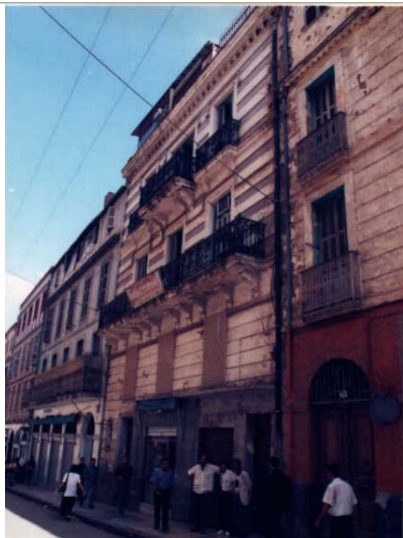
Immeubles 70,72 et 74 Rue L.Benmhidi Constantine Avant réhabilitation
