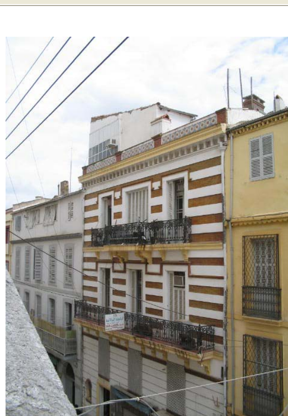
Immeubles 70,72 et 74 Rue L.Benmhidi Constantine Après réhabilitation
