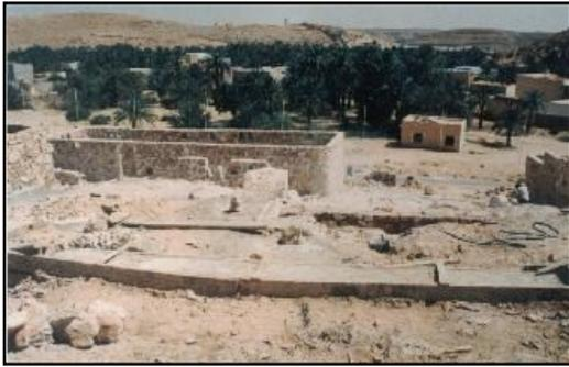
Fig. 3 – Béton banché coulé sur la roche
