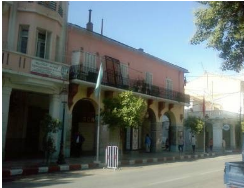
Photo 6 : Vue sur la rue du 8 mai, le balcon restent des espaces extérieurs.
