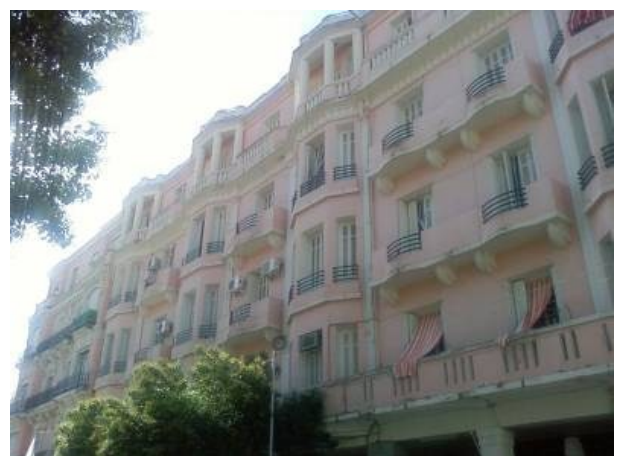
Photo 5 : Exemple de façade de la rue du 8 mai montrant
