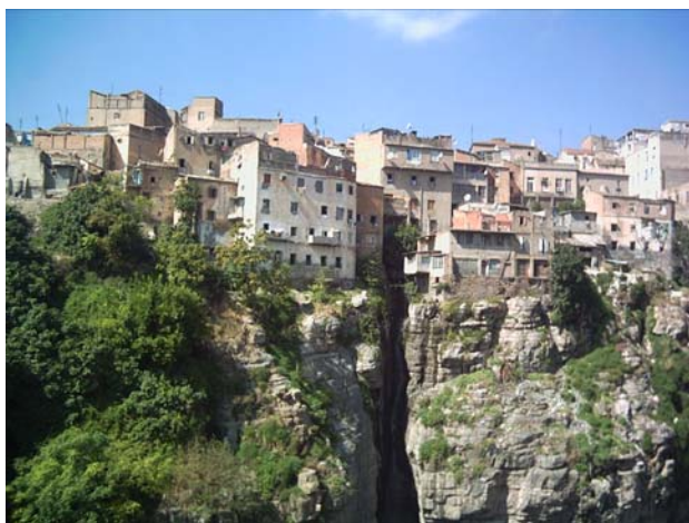
Photo 04 : Un site malentretenu Source : Auteur 2007
