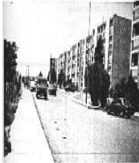
Vue d'un ensemble d'habitat collectif « Architecture type »
