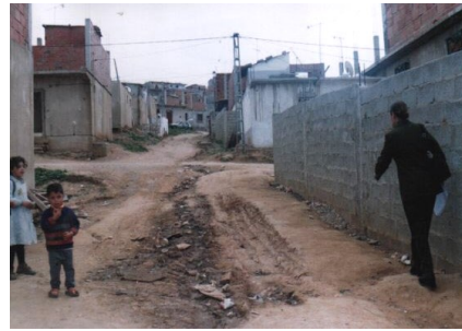
Photo 2 : L'état de non achèvement des infrastructures.
